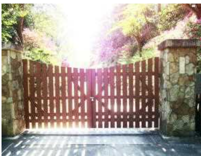
正門扉改修工事(12月)
