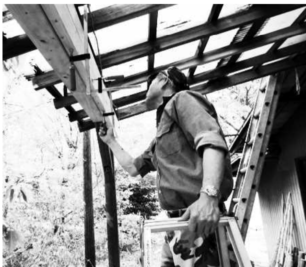
駐輪場屋根張り替え工事(4月~5月)
